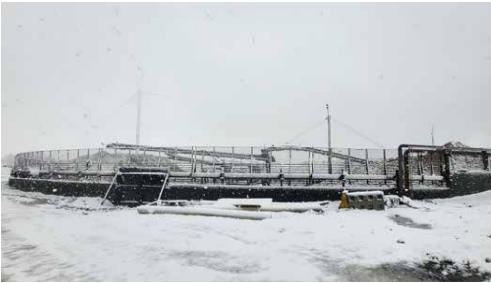
Silo de réception de betteraves sucrières de Fontenoy sous une couche de neige le 20 novembre 2025
